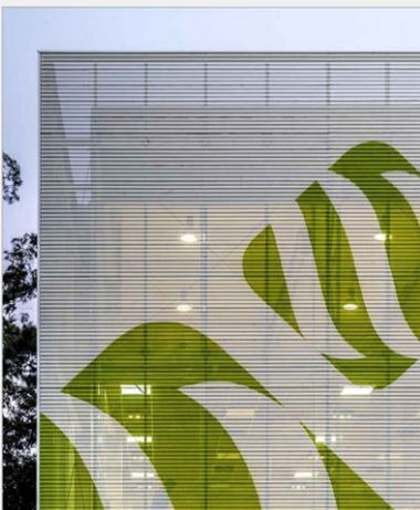
Los paneles Softwave 25 han sido diseñados para ser usados como revestimiento. Poseen una geometría única que responde fundamentalmente a requerimientos de tipo estéticos, expresada en paneles de líneas curvas. Se fabrican liso y perforado. Estos paneles, al ser perforados, pueden emplearse como elemento de control solar. En fachadas se pueden instalar con sus ondas en forma vertical u horizontal. El empalme es de tipo machi-hembra y se fija a la estructura en su parte lisa.
